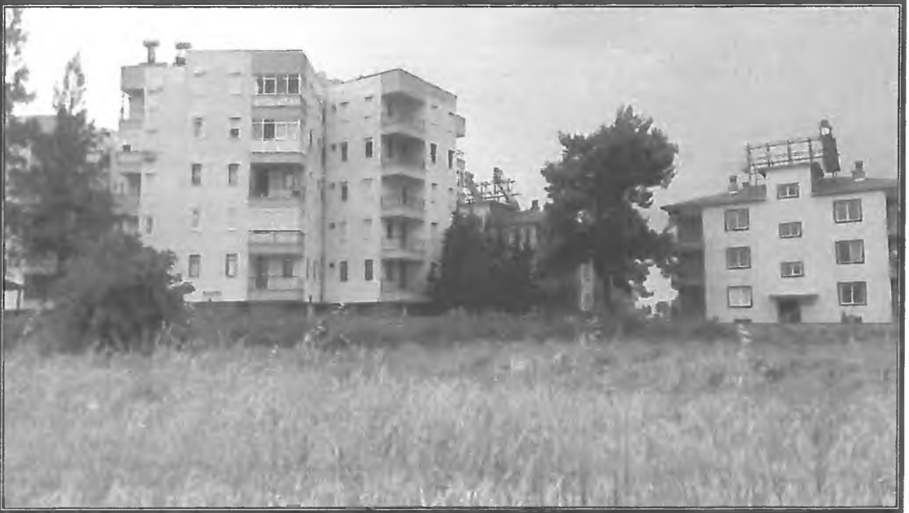
4. Planlama alanı ve komşu parsel yapılaşmaları(zemin+5kat(6kat) yapılar ve zemin+3kat(4kat) yapılar )
