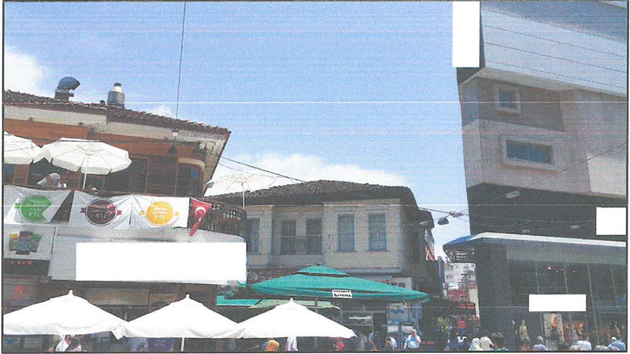
Resim 12 : 8276 ada 6 parseldeki tescilli yapı ve etrafı yapılanma görüntüleri
