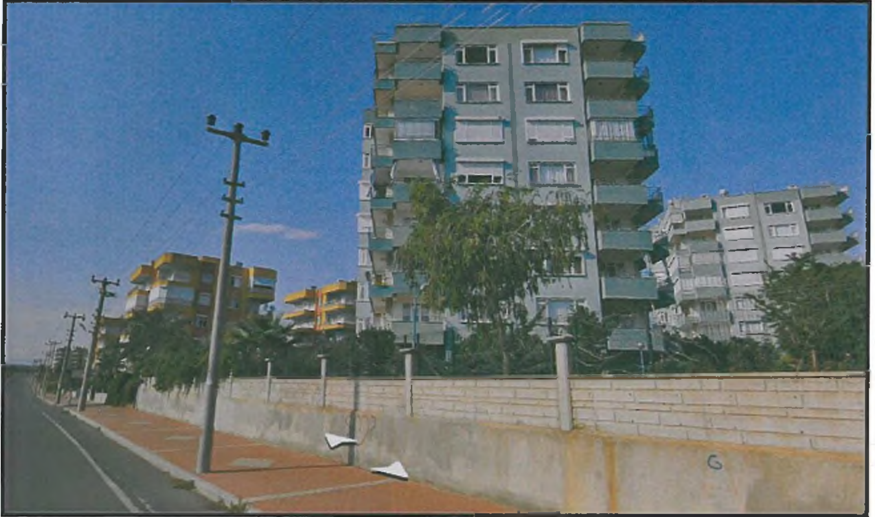
Şekil 10. 27439 ada 1 parsel üzerindeki 7 katlı binalar
