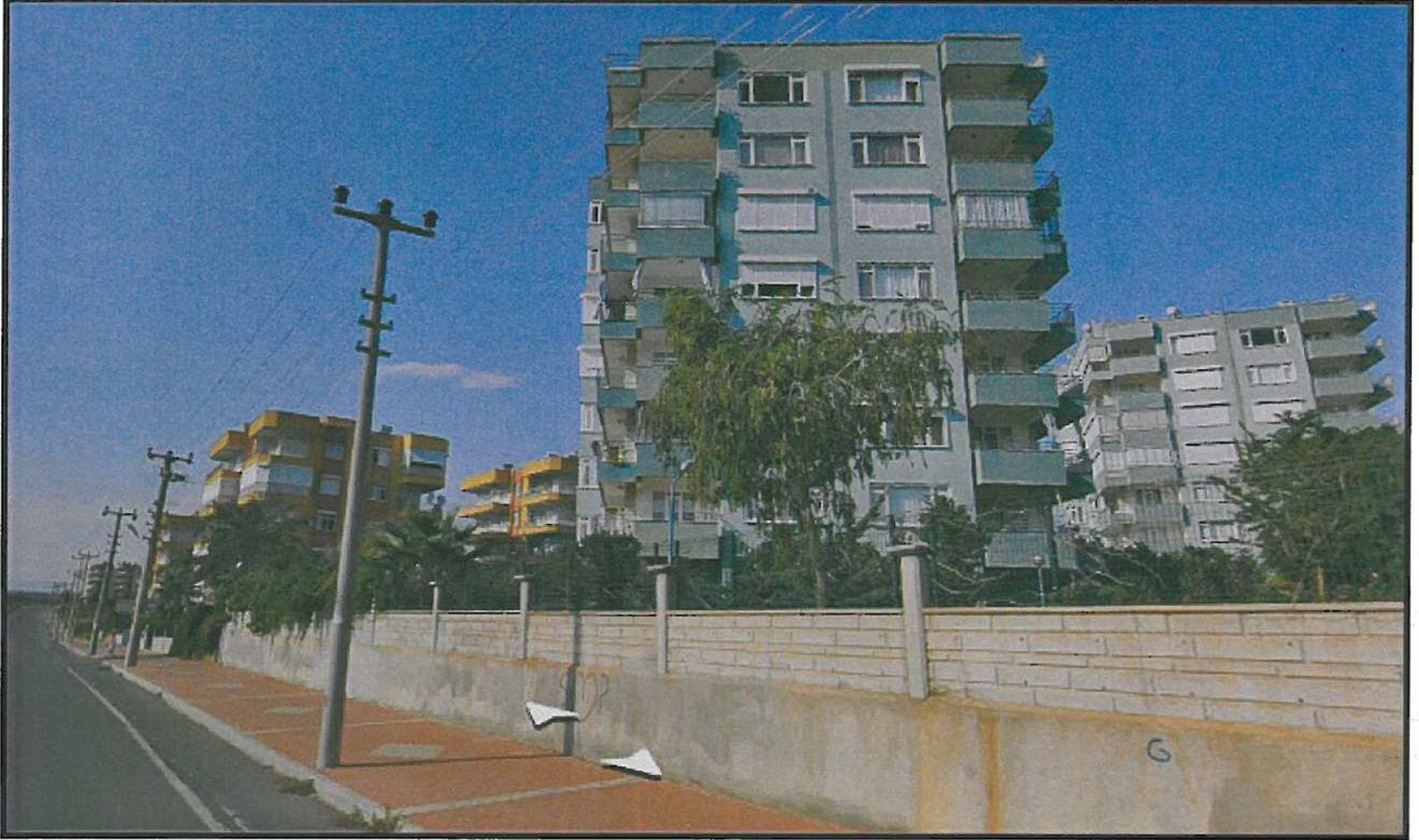
Şekil 10. 27439 ada 1 parsel üzerindeki 7 katlı binalar
