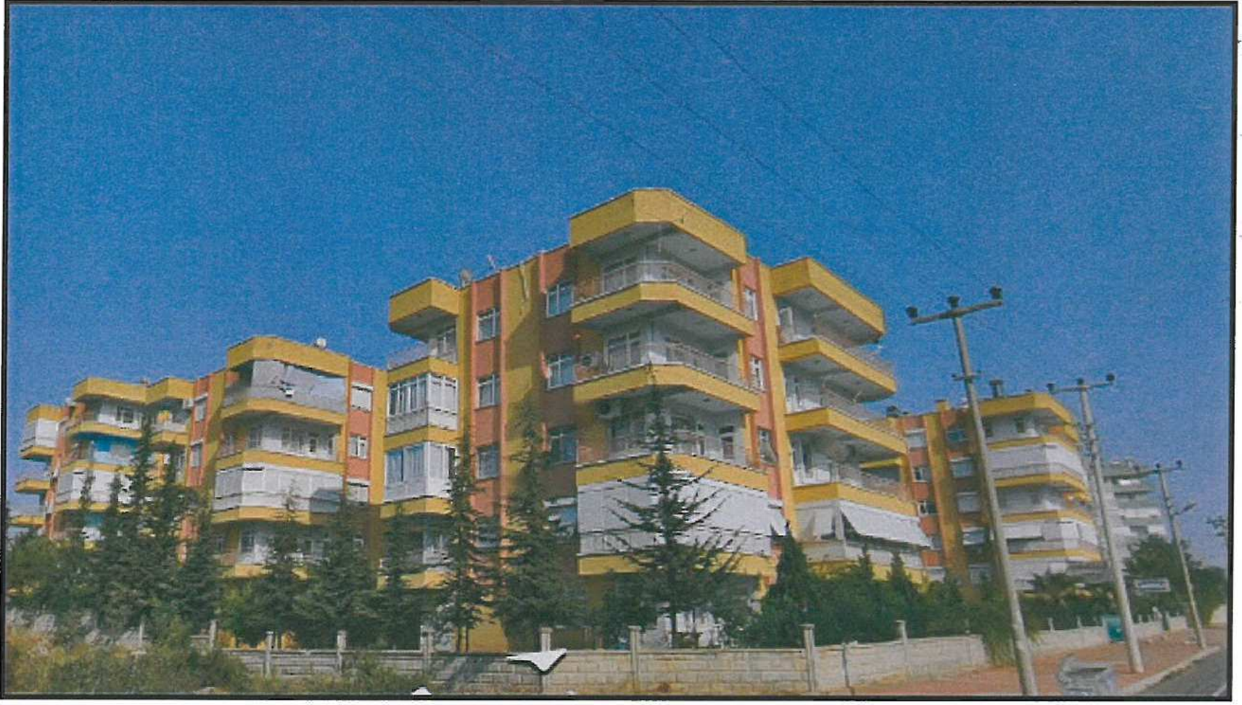
Şekil 9. 27440 ada 1 parsel üzerindeki kooperatif binaları
