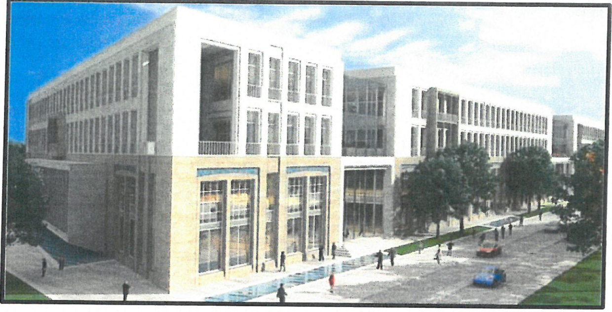
Foto 14: Han tipi mimarinin modern yapılaşma ile yorumu
