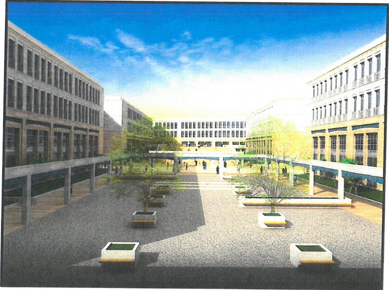
Foto 15: Han tipi mimarinin modern yapılaşma ile yorumu
