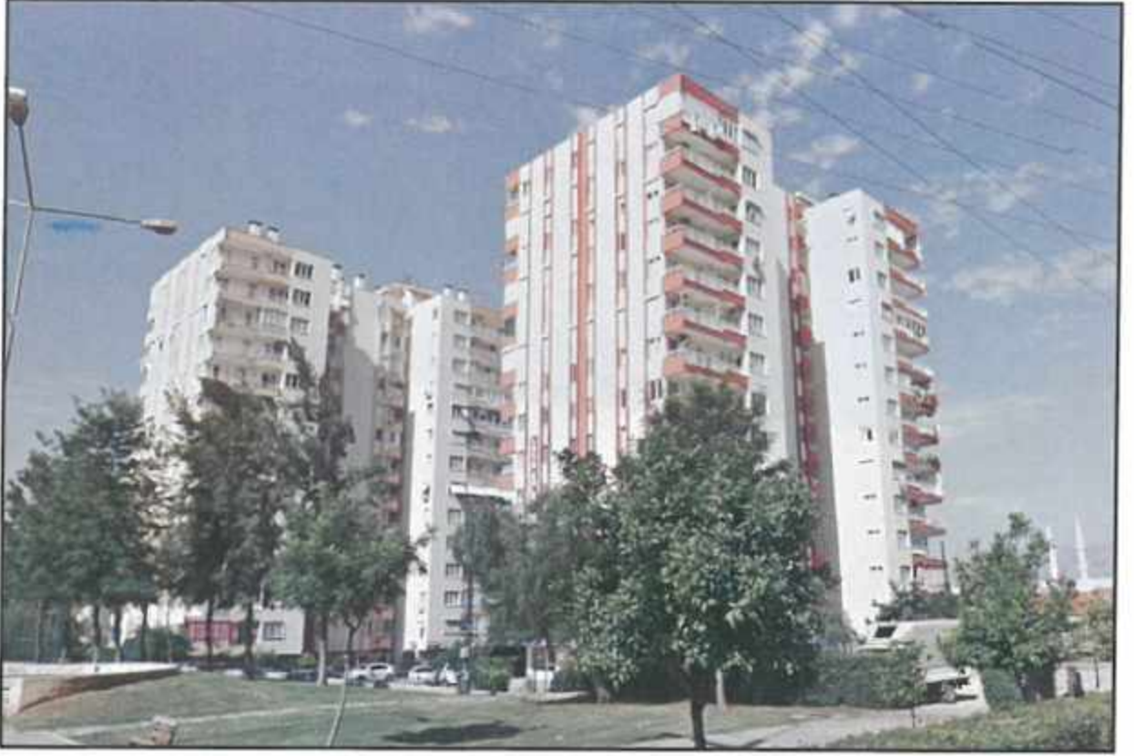
Şekil 9. 27777 ada 1 ve 2 parselin 3093. sokak üzerinden görünümü
