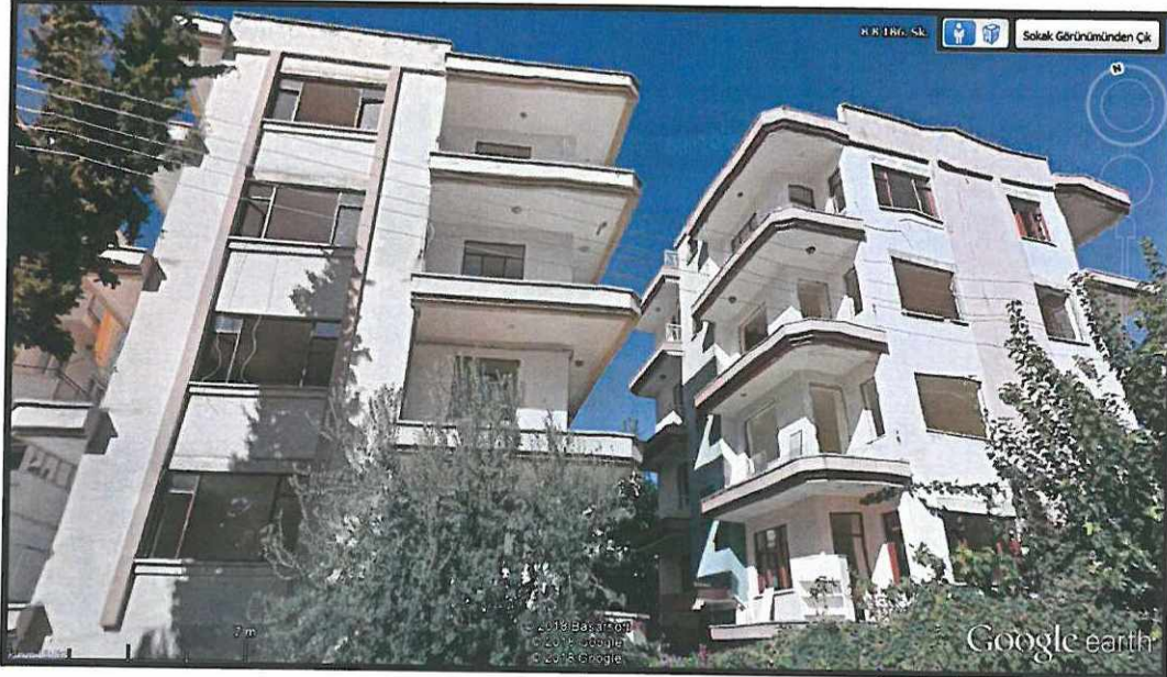
Şekil 12. 1528 ada 8 ve 9 parsel üzerindeki yapıların şuan ki durumu
