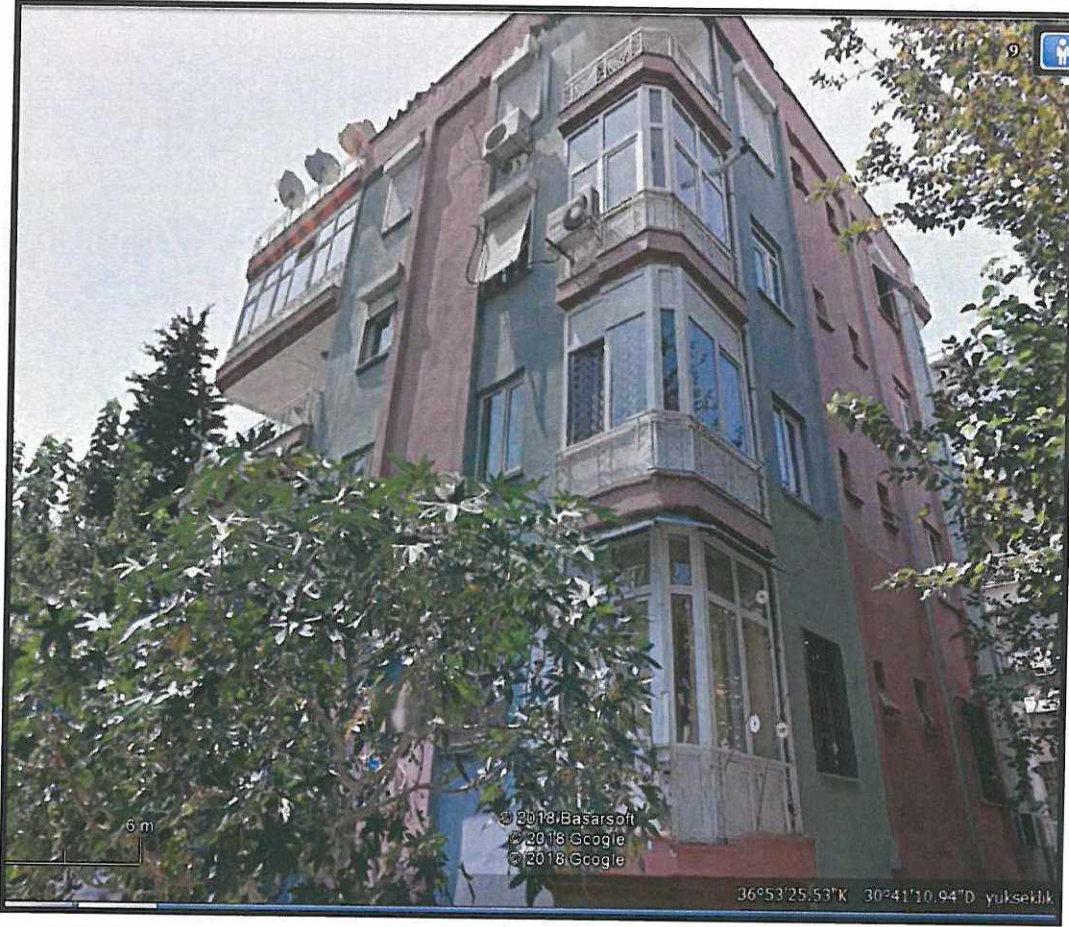
Şekil 11. 1528 ada 8 parsel üzerindeki yapının Riskli Yapı İlanından önceki durumu
