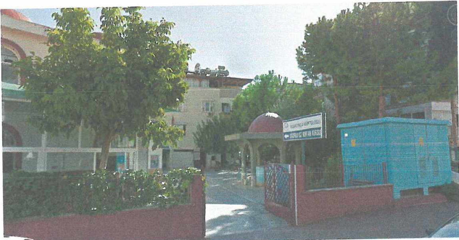
Resim 2 : Uğurlu Camii ve Kur-an Kursu ile Şadırvan ve trafo
