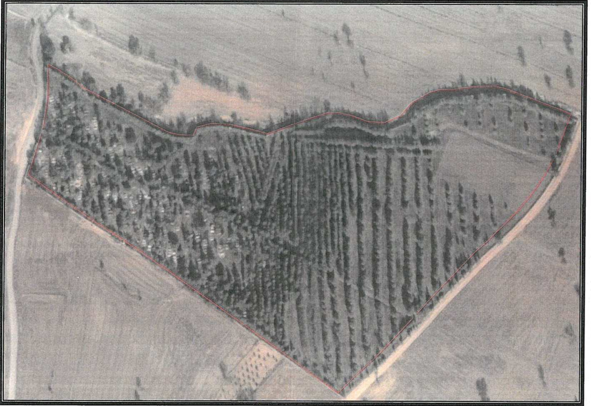
Şekil 2. Hava Fotoğrafı ve zemin alımı yapılan Mezarlık Duvarı
