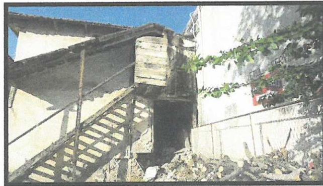
1 Envanter Nolu Bina ( Yan Cephe )
