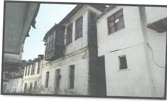
20 Envanter Nolu Bina ( Ön Cephe )
