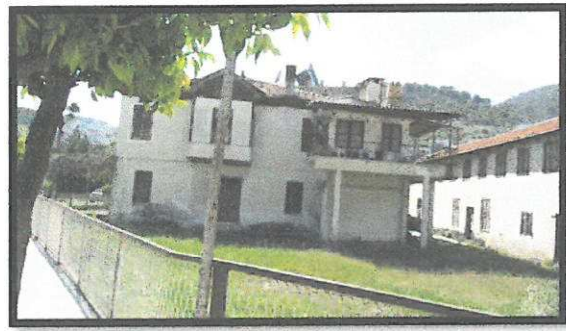
1 Envanter Nolu Bina ( Yan Cephe )
