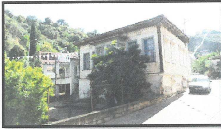
11 Envanter Nolu Bina ( Ön Cephe )
