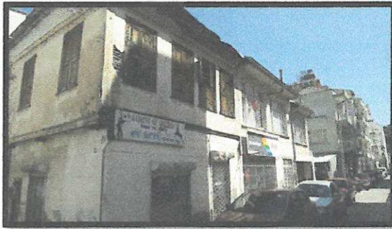
8 Envanter Nolu Bina ( Ön Cephe )
