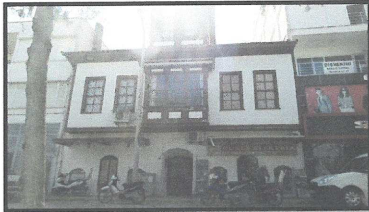
10 Envanter Nolu Bina ( Ön Cephe )
