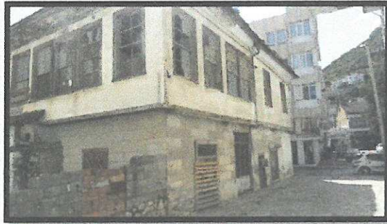
8 Envanter Nolu Bina ( Yan Cephe )
