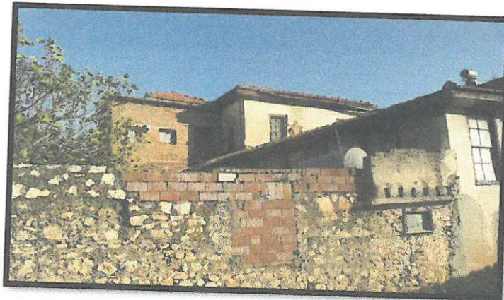
20 Envanter Nolu Bina ( Yan Cephe )
