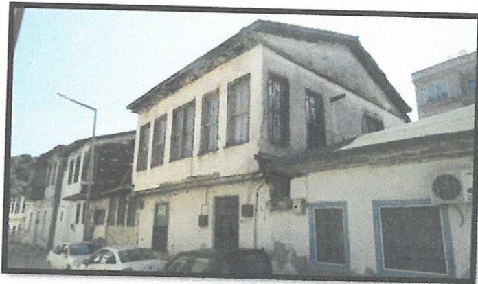
22 Envanter Nolu Bina ( Ön Cephe )
