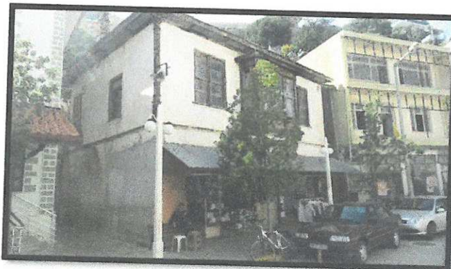
4 Envanter Nolu Bina (Öne Cephe )
