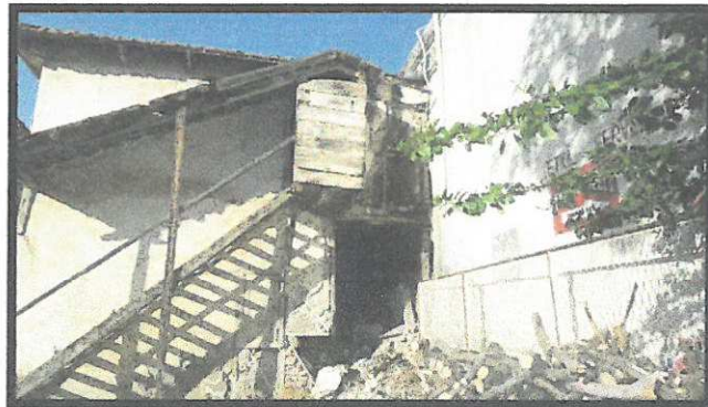
1 Envanter Nolu Bina ( Yan Cephe )
