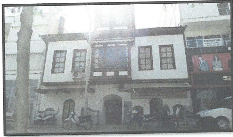
10 Envanter Nolu Bina ( Ön Cephe )
