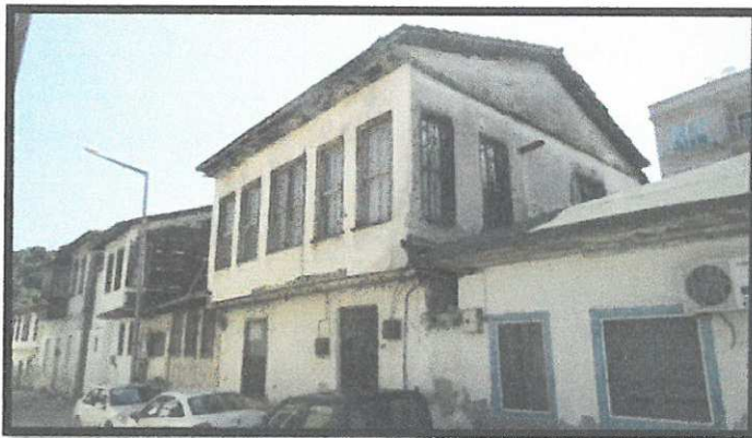
22 Envanter Nolu Bina ( Ön Cephe )
