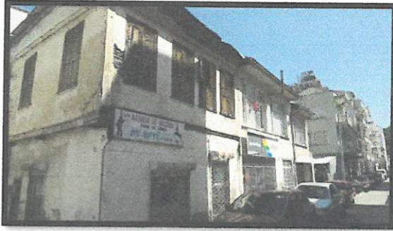
8 Envanter Nolu Bina ( Ön Cephe )
