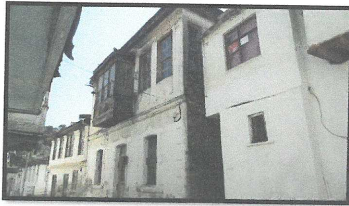
20 Envanter Nolu Bina ( Ön Cephe )
