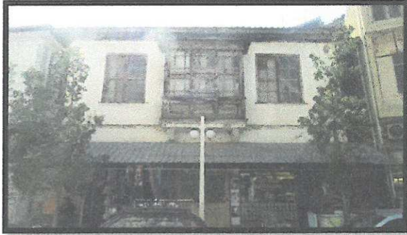
4 Envanter Nolu Bina ( Ön Cephe )
