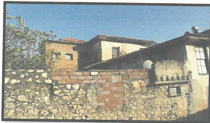
20 Envanter Nolu Bina ( Yan Cephe )
