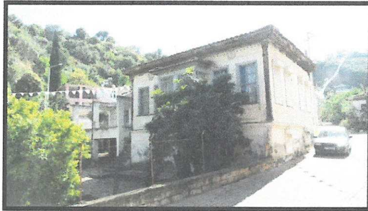
11 Envanter Nolu Bina ( Ön Cephe )
