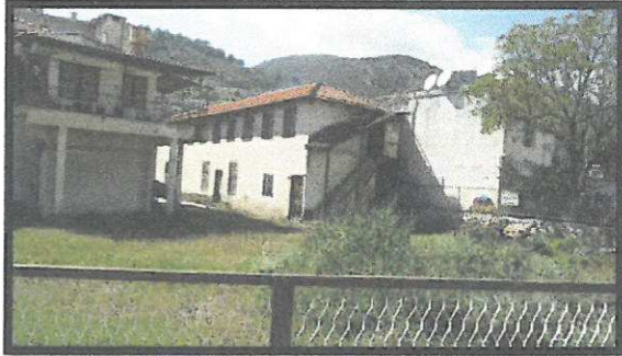
1 Envanter Nolu Bina ( Yan Cephe )
