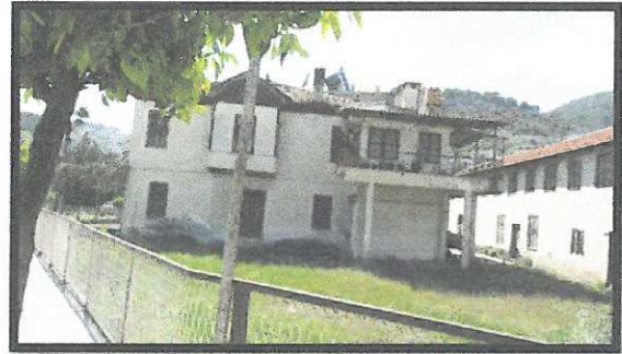
1 Envanter Nolu Bina ( Yan Cephe )
