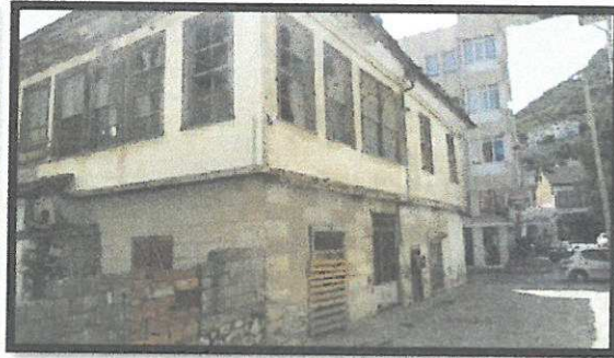
8 Envanter Nolu Bina ( Yan Cephe )
