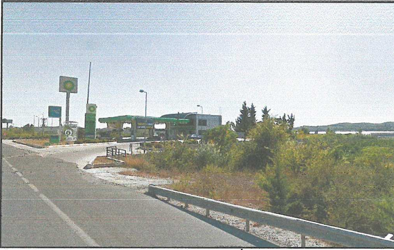
Resim 3: Planlama Alanındaki Akaryakıt ve Servis İstasyonu Alanı
