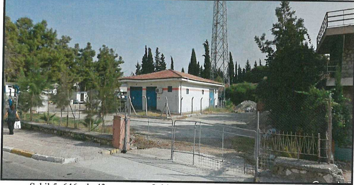
Şekil 5. 646 ada 43 mevcut trafo binası
