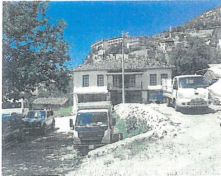
Fotoğraf 5- Kent Meydanı alanı, korunacak tescilli yapı ve çevresinin durumu
