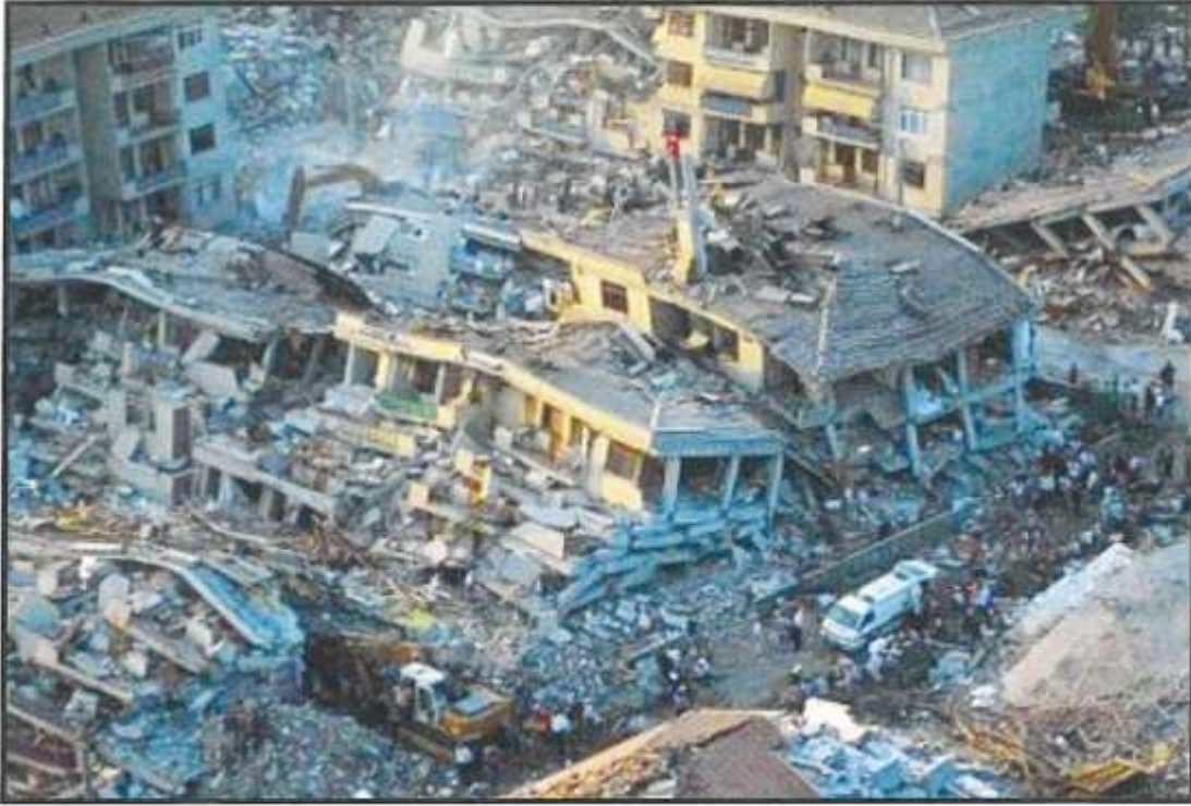
Şekil 6. 17 Ağustos 1999 Marmara Depremi sonucu enkaza dönmüş konut alanı. Resmi raporlara göre, 17.480 ölüm, 23.781 yaralı oldu. 505 kişi sakat kaldı. 285.211 ev, 42.902 iş yeri hasar gördü.
