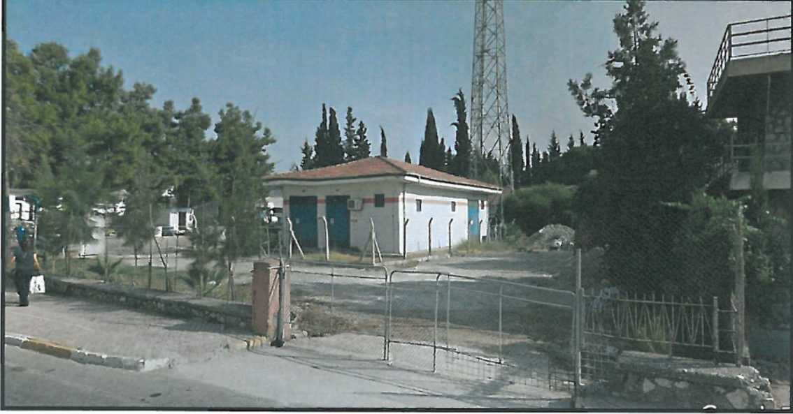
Şekil 5. 646 ada 43 mevcut trafo binası
