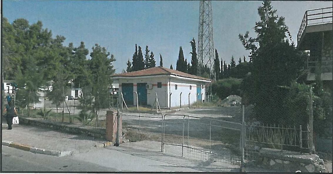
Şekil 5. 646 ada 43 mevcut trafo binası
