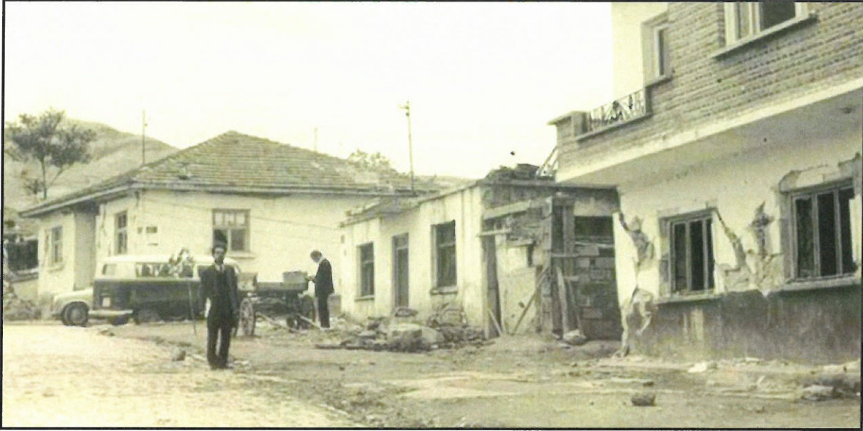
Şekil 4. 12 Mayıs 1971 Burdur depreminden sonra Burdur' da bir sokak. Burdur ve çevresinde gece meydana gelen 6,2 şiddetli depremde 57 kişi öldü, 1.162 ev yıkıldı .
