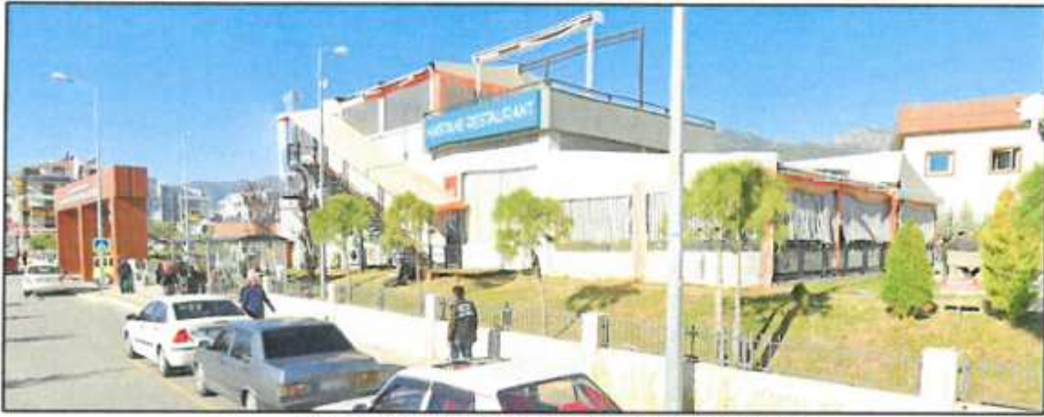
Şekil 5. Poliklinik Girişinde Bulanan Kantin Yapısı
