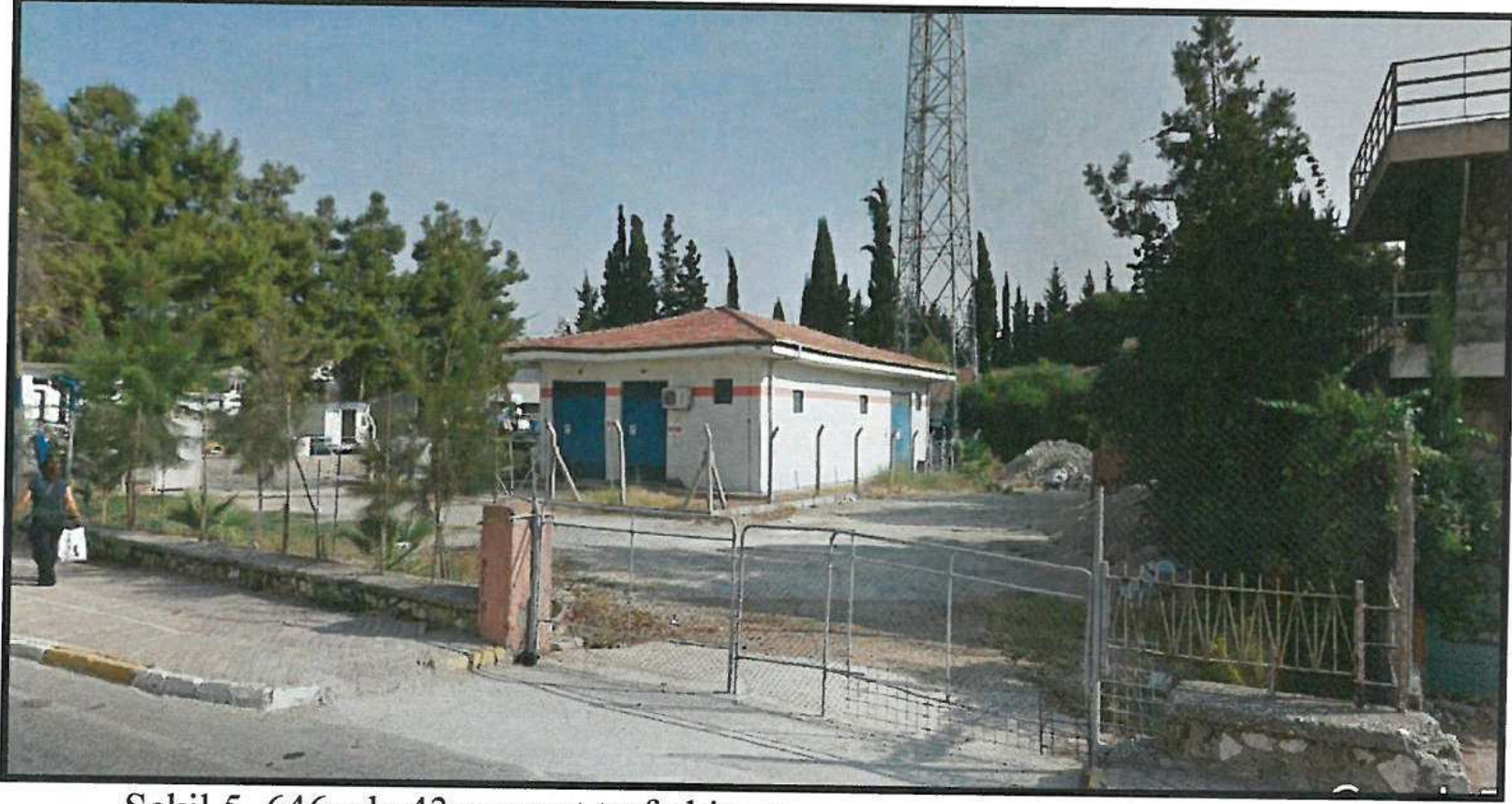
Şekil 5. 646 ada 43 mevcut trafo binası
