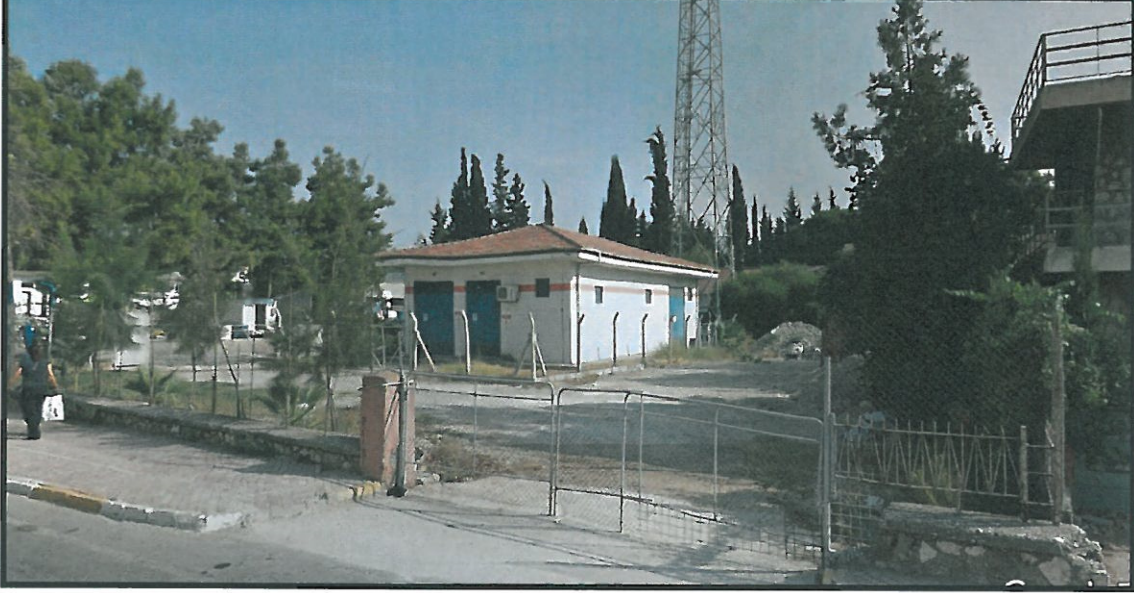
Şekil 5. 646 ada 43 mevcut trafo binası
