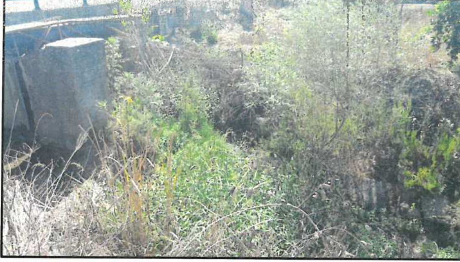
Resim 10: DSİ Su Kanalı İçinde Görülen Yapı Kalıntısı-2
